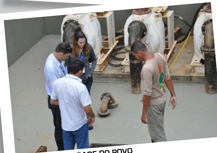
INSPEÇÃO NA CIDADE DO POVO
